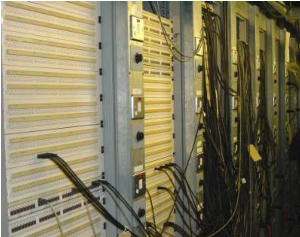
Mikrofon- und Lautsprecher- Verteiler in der Royal Opera in London
