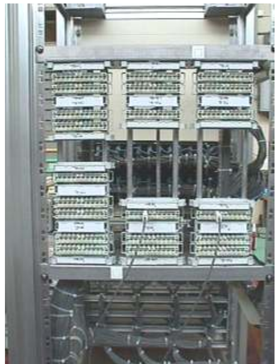
KRONE-LSA-PLUS Verdrahtungstechnik
